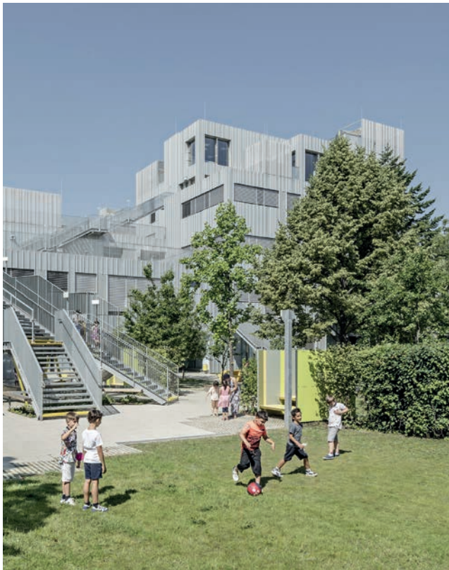
„Volks- und Berufsschule Längenfeldgasse“, Wien 2020, PPAG architects ztgmbH
