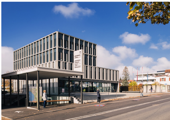
Straßenfassade mit abgetrepptem Vorplatz | integrierter Bushaltestelle
