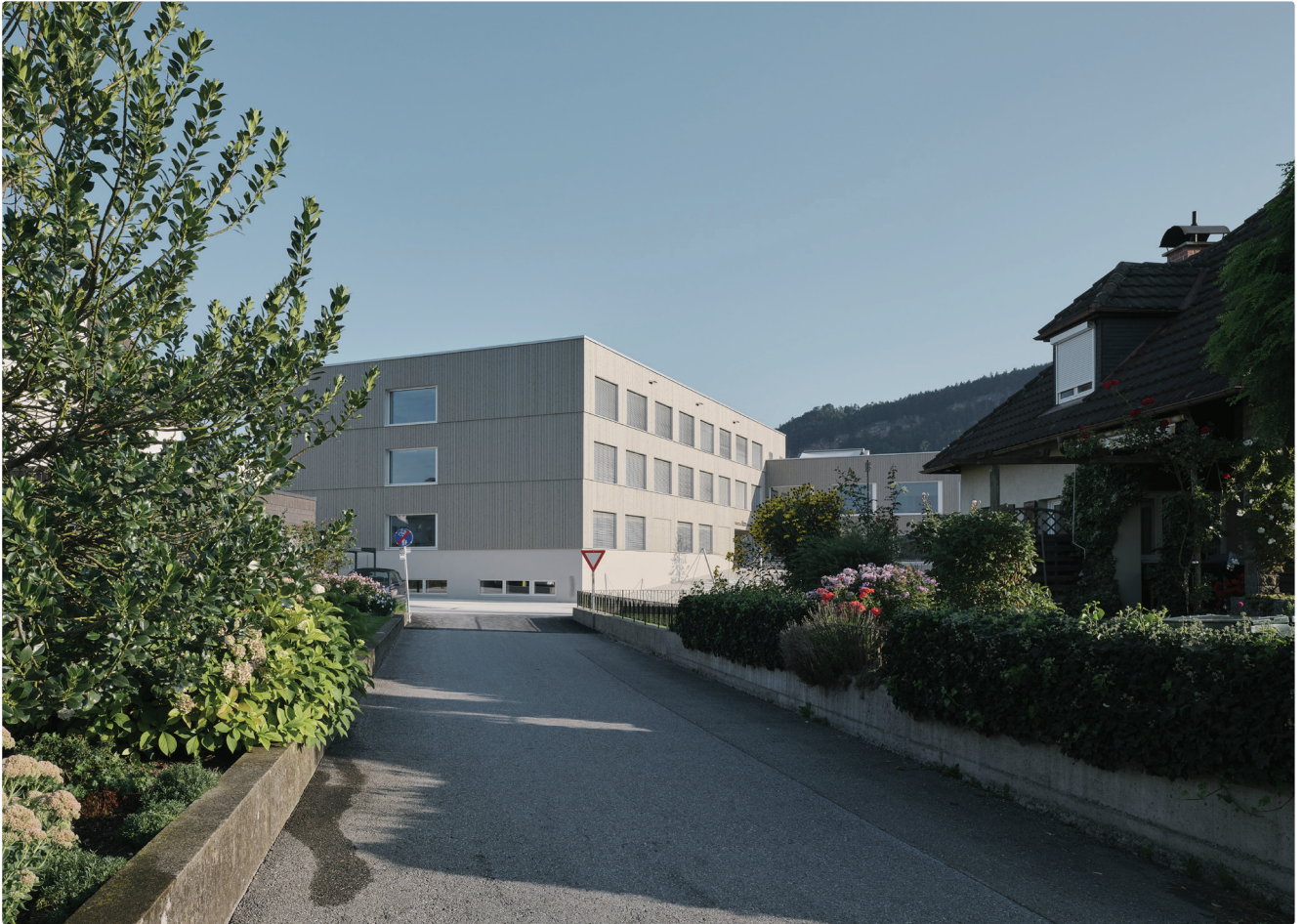
Blick von Süden, im Vordergrund der neu verkleidete Bestandsbau
