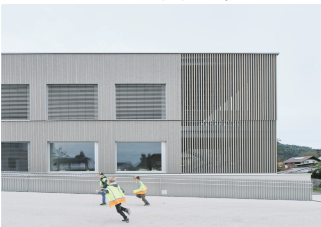
Pausenhof und Pergolaanbau
