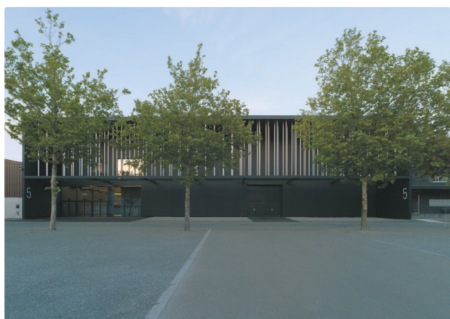
Ansicht | Blick vom Innenhof
