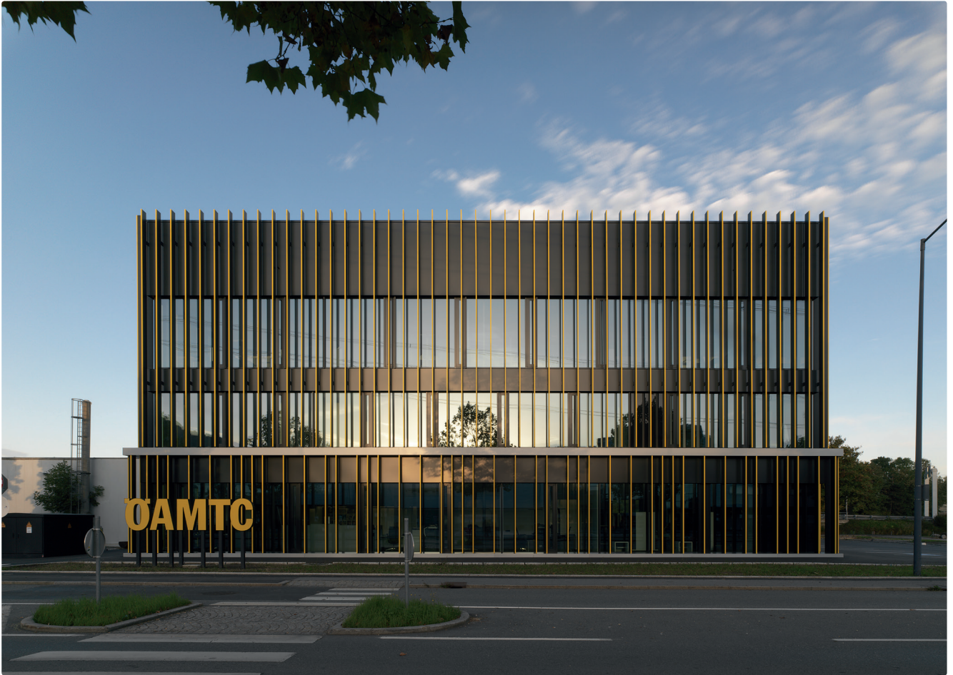
Ostansicht, Blick vom Messeareal auf das neue ÖAMTC-Gebäude
