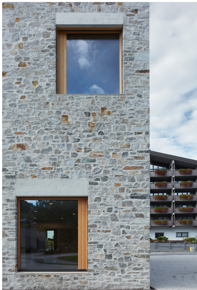
Der sichtbare Teil der Betonstürze nimmt die Breite der Fenster auf.
