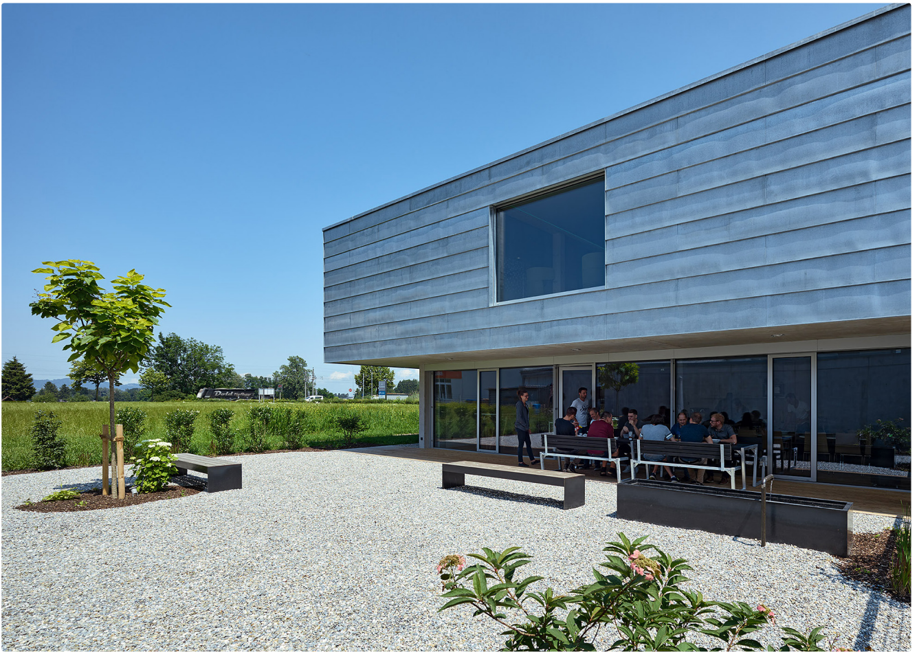
Zum Süden erweitert sich der Aufenthaltsraum zu einer großzügigen und überdachten Mitarbeiter|innen-Terrasse
