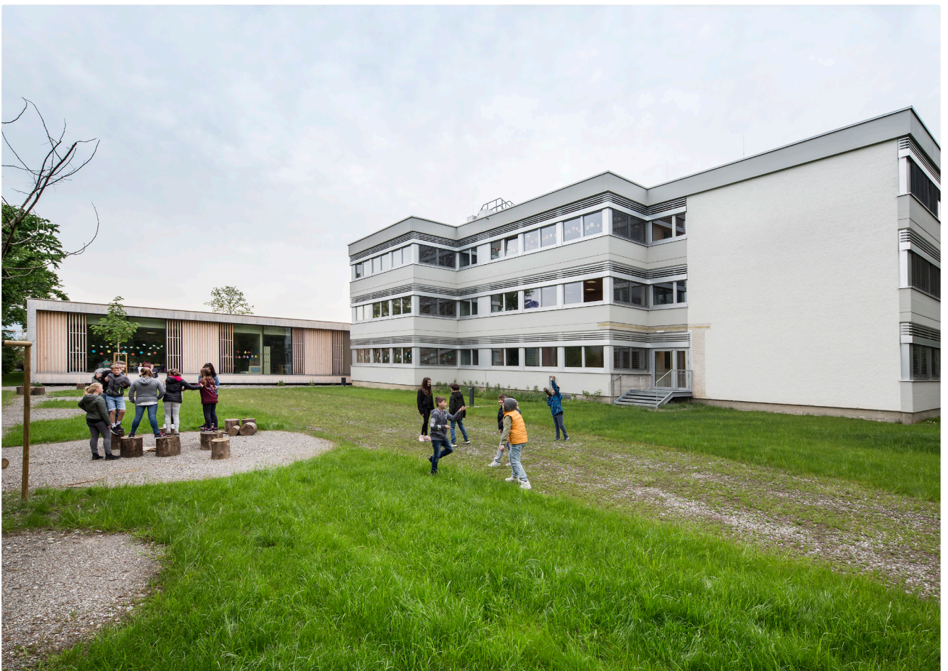
Bestand und Neubau rahmen den Schulgarten
