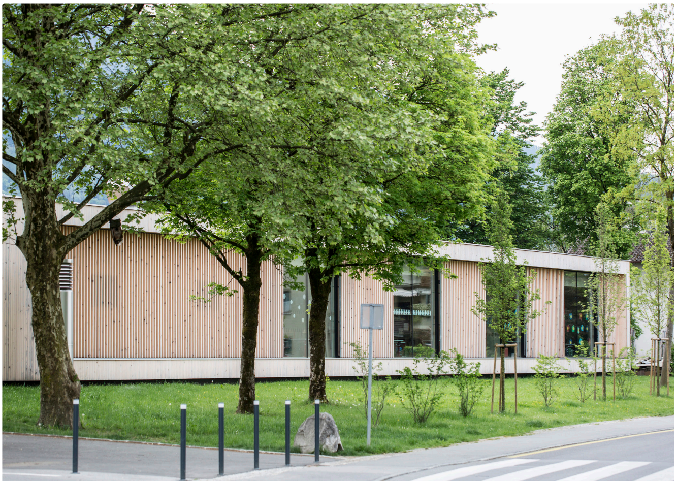
Der neue eingeschobige Klassentrakt zur Schubertstraße
