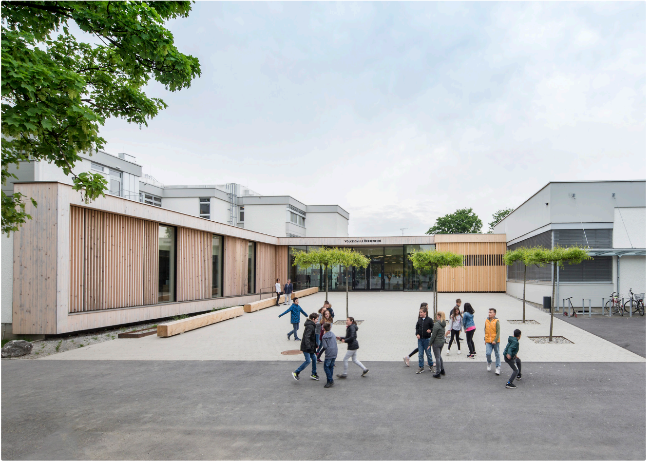
Neuer Hauptzugang, links der Verwaltungsteil, rechts die bestehende Turnhalle
