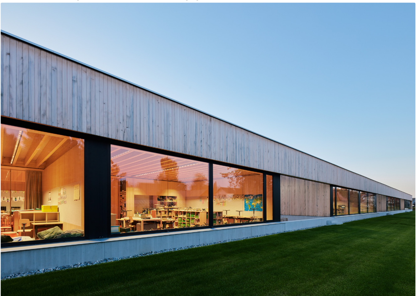
Bis auf die erdberührenden Teile ist die ganze Schule aus Weißtanne und Glas gebaut
