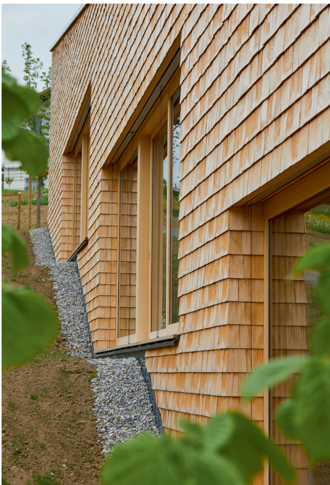
Detail: hinterlüftete Schindelfassade
