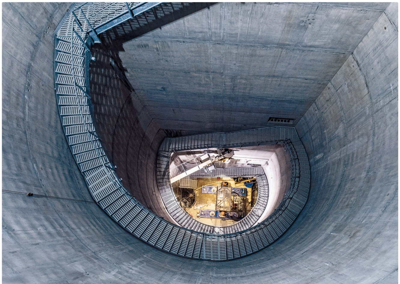
Blick in den Schützenschacht
