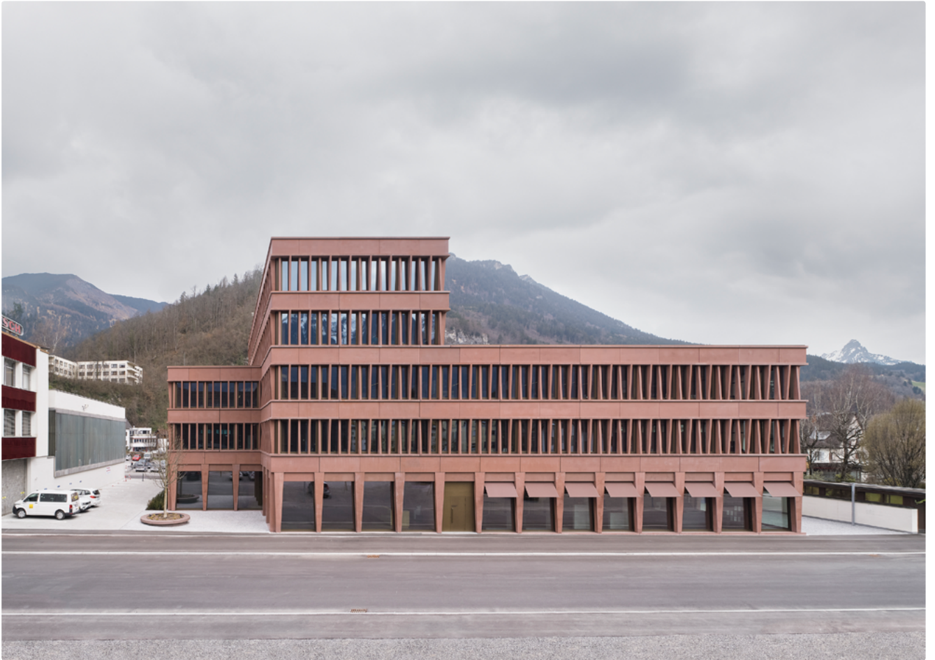
Die Südansicht, links der Vorplatz mit Haupteingang
