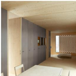
**System3** | Das mobile Wohnsystem ist beweglich, erweiterbar und variabel. Es besteht aus zwei Teilen, die in zwei Übersee-Container passen. Die Serviceeinheit ist als Box vorfabriziert und enthält alle Leitungen und Installationen, Küche, Bad Erschließung mit Treppe. Der zweite Teil besteht aus drei Seitenwänden mit Lichtöffnungen, Fußboden und Decke. In einem Tag ist das Haus errichtet. Die vorfabrizierten Teile werden zusammengefügt und abgedichtet.
