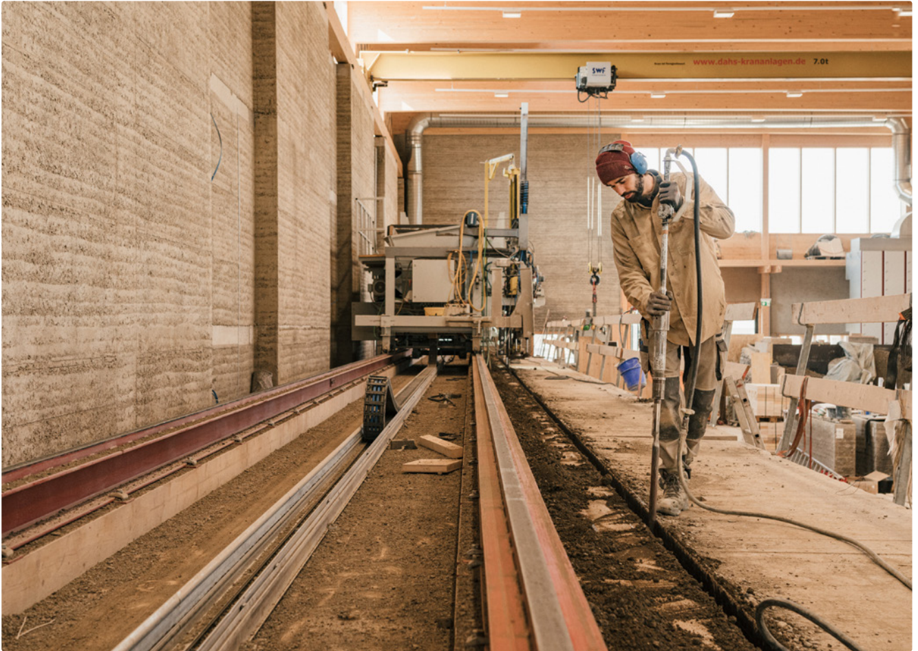
Die Vorfertigungsanlage (hier ein Mitarbeiter beim Stampfen) in verschiedenen Ansichten.
