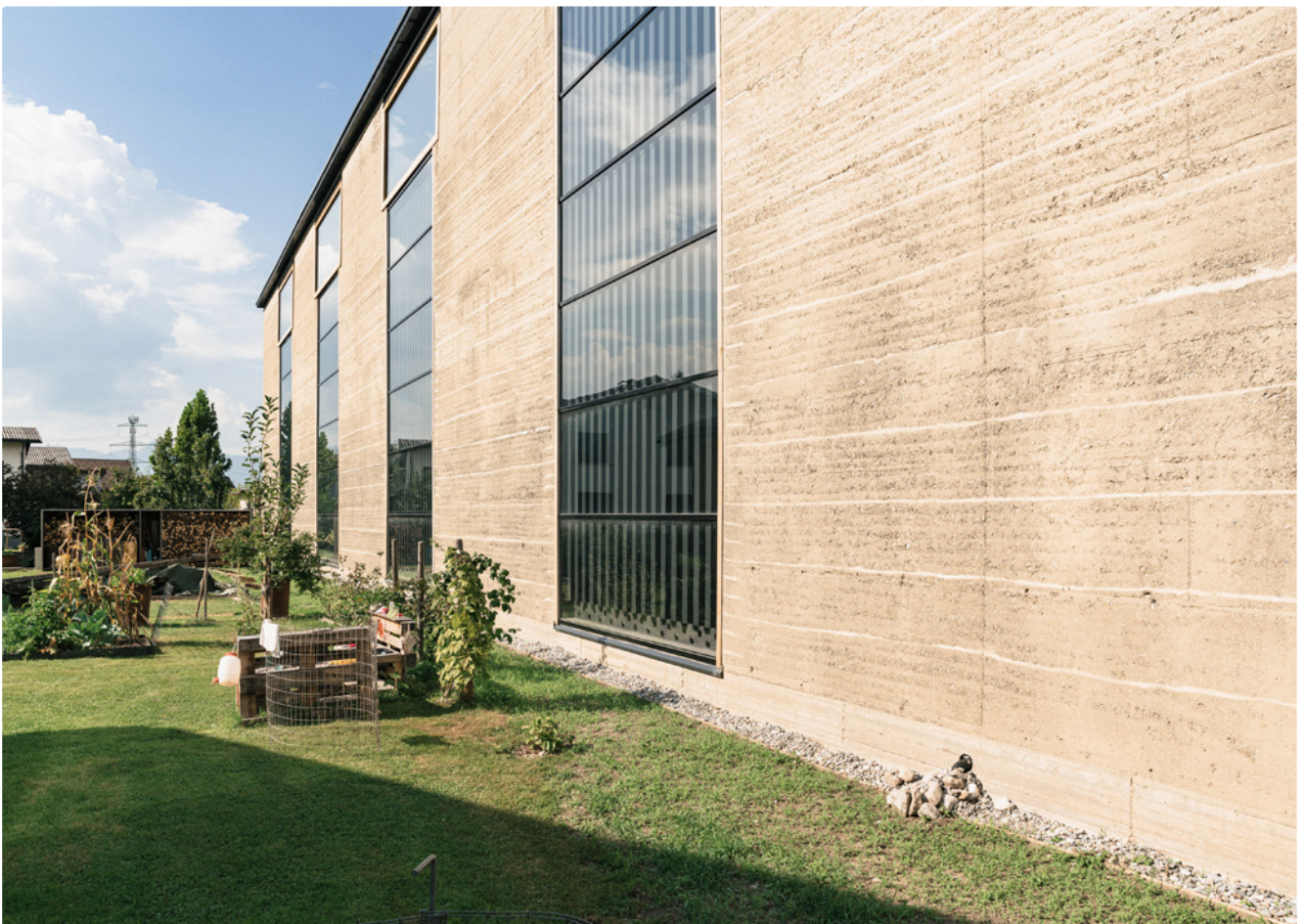
Die Südfassade ist komplett aus Lehm, die zurückversetzten Mauerscheiben mit Luftwärme-Kollektoren aufgefüllt.
