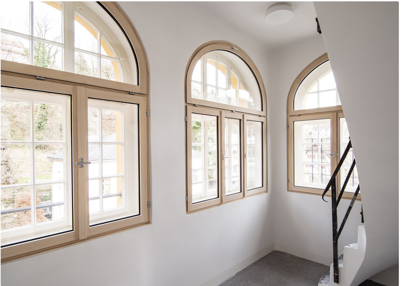
Das Treppenhaus blieb weitgehend erhalten. Neu sind vor allem die zusätzlichen Innenfenster aus Weißtanne.
