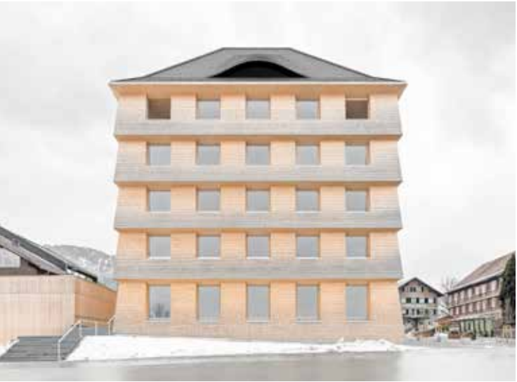
MASS UND FORM. Der Fünfgeschoßer ist geprägt von wiederholenden, starken Elementen und einem Walmdach.
