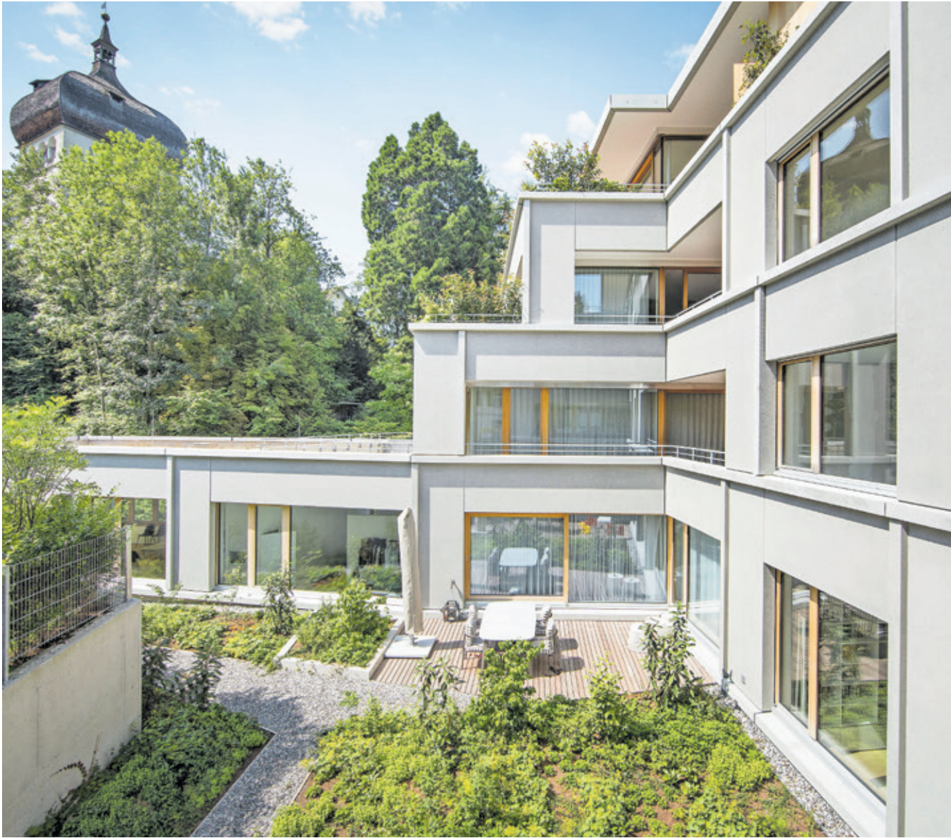
Die eleganten Fassadenelemente aus Sichtbeton prägen auch die Rückseite dieses Hauses, das den Übergang zur Natur mit ausladenden Terrassenlandschaften feiert.
