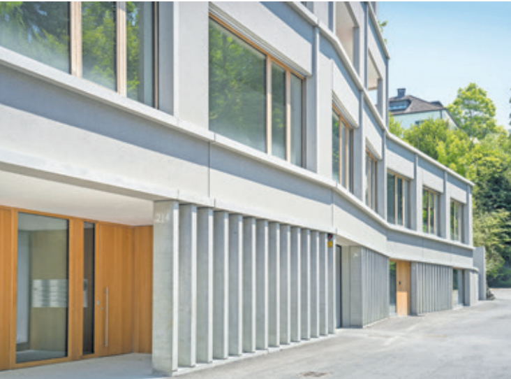
URBANE MISCHUNG Die Sockelzone beherbergt Wohnungen und Büros. Sie ist mit 3,05 Meter leicht überhöht und mit einer Reihe schmaler Sichtbetonpfeiler sehr stilvoll gestaltet.
