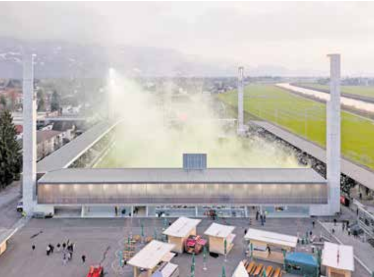
TECHNISCHE ASYMMETRIE: Aus Rücksicht auf die angrenzende Wohnbebauung sind die vier Eckpylonen mit unterschiedlich vielen Scheinwerfern ausgestattet, die das Feld verschieden weit ausleuchten.
