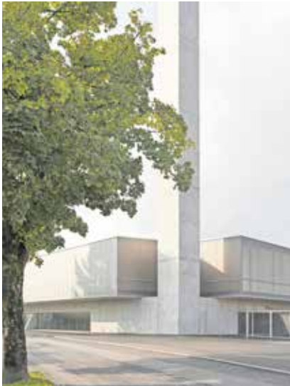
TRANSPARENZ: Je nach Tageslicht und künstlicher Beleuchtung gibt sich das Stadion mal offener, mal geschlossener.
