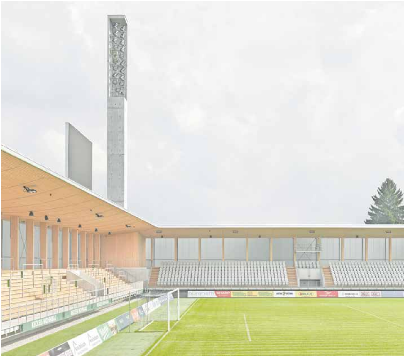
Das Spielfeld wurde aus Gründen der Entwässerung wie ein sehr, sehr flaches Walmdach mit 0,5 Prozent Gefälle modelliert. Die Vordächer aus vorgefertigten Holzkassetten bieten 100-prozentigen Witterungsschutz.
