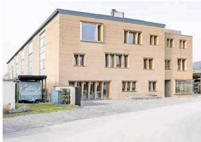
GESTAMPFTE ERDE. Der Baukörper aus gestampfter Erde ist freitragend, seine Lehmfassaden sind unbehandelt und der Witterung ausgesetzt.
