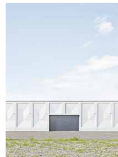
UNVERWECHSELBAR Die 2,45 Meter breiten, 4,5 Meter hohen Elemente sind von einer plastischen Struktur gegliedert.
