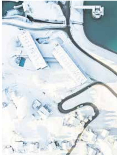
ANSPRUCH Trotz oder wegen der Größe des Hotelkomplexes war das Eingehen auf die Topographie besonders wichtig.
