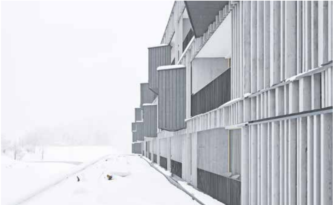
Vertikal mit vorvergrauten und unterschiedlich breiten Latten aus Lärchenholz verkleidet sind die Fassaden der zwei Bettentrakte.
