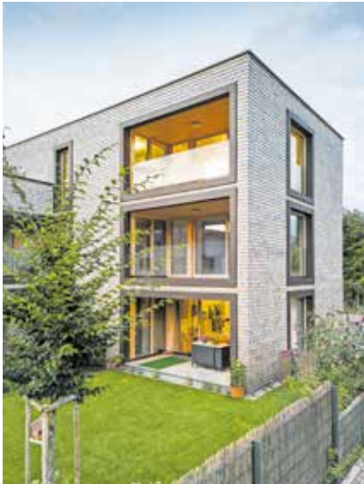
HYBRID. Holzhybridbau mit Stahlbetontragwerk, Holzwänden, Lehmputz und zirkulären Fichtenschindeln aus der Region.
