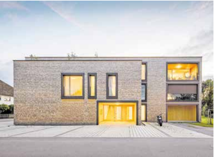
FASSADE. Naturbelassene Fichtenschindeln mit konturierten Öffnungen geben dem Gebäude Ausdruck, Tiefe und Präsenz.
