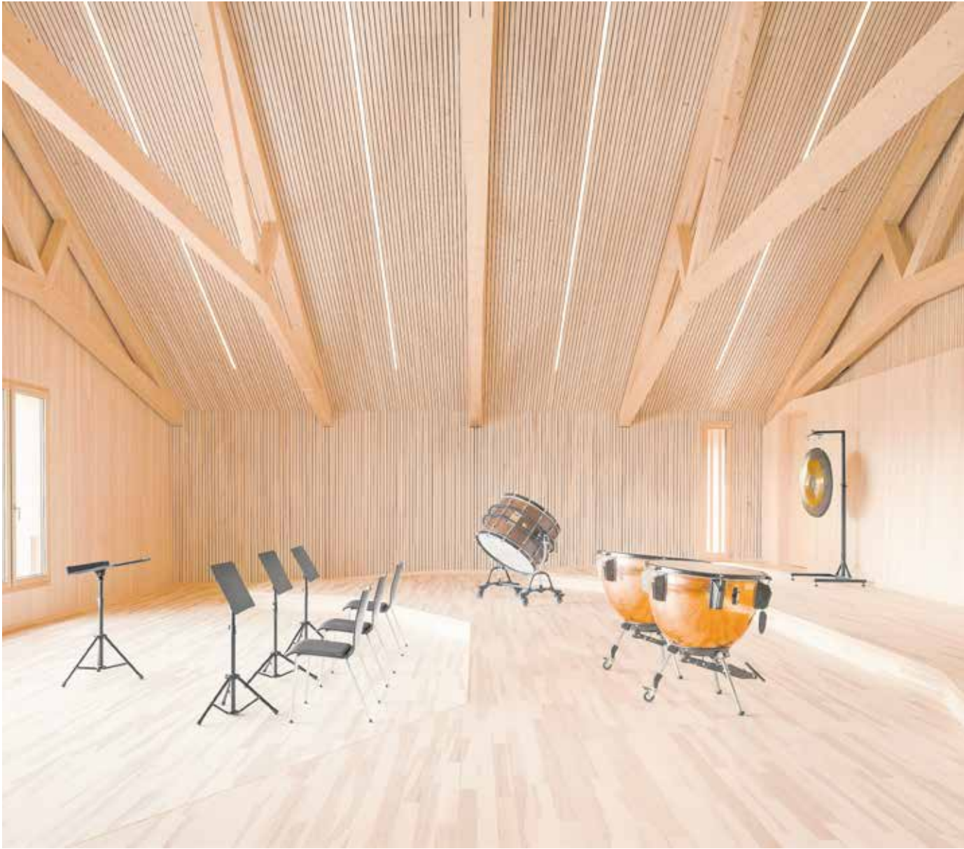
Das Fachwerk der Holzleimbinder überspannt die insgesamt 18 Meter Spannweite vom neuen Probesaal des Musikvereins souverän stützenfrei.
