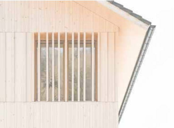
DIE NEUE AUFSTOCKUNG wird an ihrer durchgehend vertikalen Lattung, die auch vor die Fenster gezogen wurde, ablesbar.
