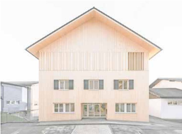
DIE SCHMALEN, VERTIKALEN FICHTELATTEN der neuen Holzfassade verleihen dem Haus eine gewisse Eleganz.
