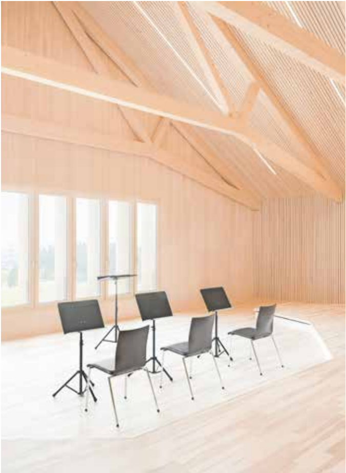
Die Holzleimbinder lösen die Lasten intelligent auf, wirken raumbildend und streuen die Akustik.
