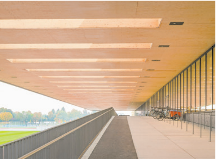
GROSSE GESTE Das rekordverdächtige Holzdach des TUM-Campusgebäudes kragt 18,7 Meter aus.
