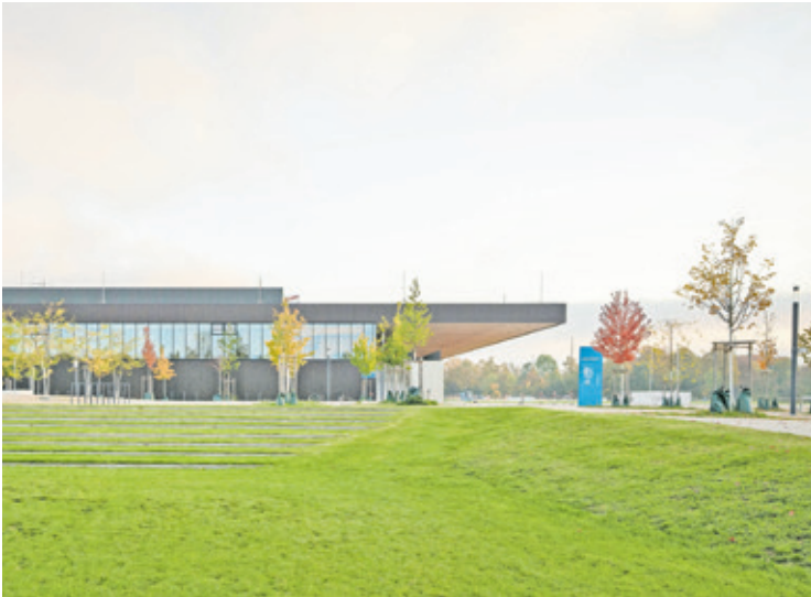
DER GROSSE HOLZBAU mit zwei Geschossen ist am Rand des Münchner Olympiaparks in die Landschaft eingebettet.
