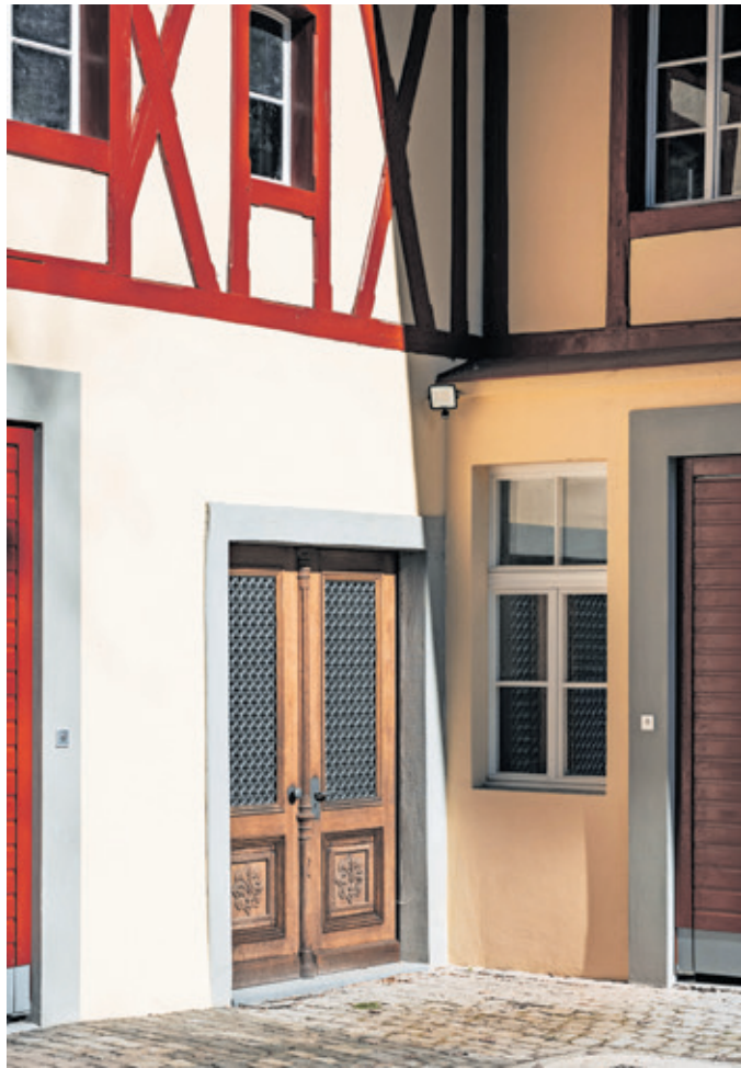
Bestehende, jahrhundertealte Elemente wurden restauriert und wiederverwendet.
