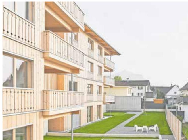
**HOLZFASSADE.** Die gesamte Fassade ist mit Fichtenholz belegt. Konstruktiv ist es aber ein Mischbau.
