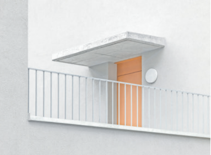
ZIEGEL, PUTZ UND HOLZ Massivbau mit tragenden Betondecken und Betonwänden und eine Außenhülle aus verputztem zweischaligen Mauerwerk.
