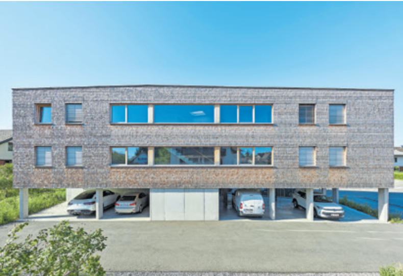
HOHES HAUS Der Grundwasserspiegel ist sehr hoch, deshalb ist das Gebäude aufgeständert. In der Mitte befindet sich der Erschließungskern
