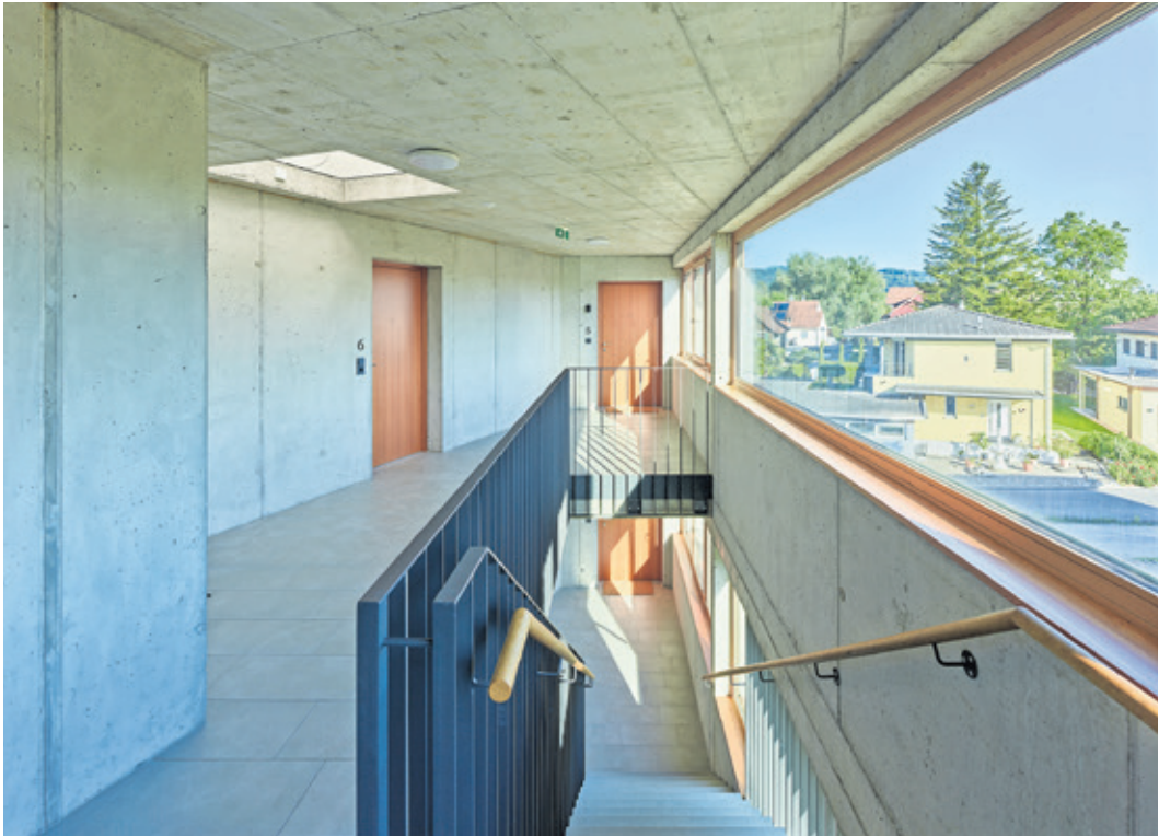
Das Innere ist rau, robust und sichtbar lässig. An den Wänden Standardtäfer aus Fichte, am Boden ein gespachtelter Estrich, die Decke unbehandelter Beton.
