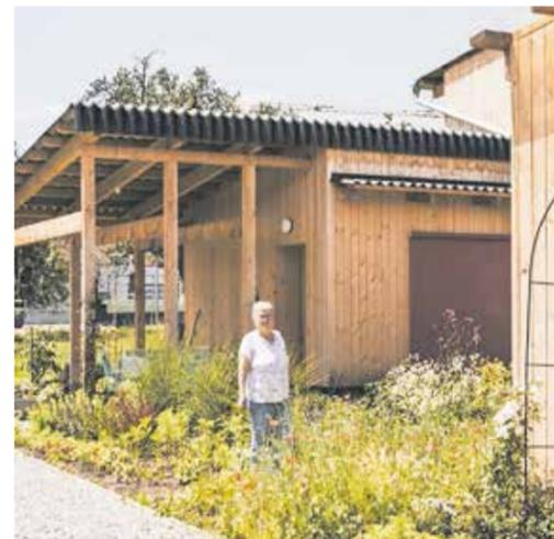
**DIE STÜTZEN** sind so bemessen, dass man das Haus noch um ein Geschöß und ein ausgebautes Dach aufstocken kann.
