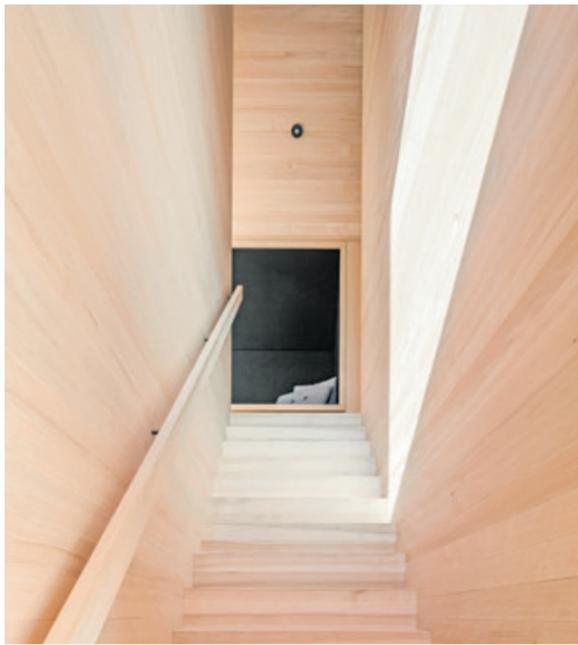
Im Inneren des Hauses wurde durchgehend Sichtholz verwendet, man entschied sich für Weißtanne, eine besonders helle Holzart. Weißtanne für Wand und Decke, massive Dielen aus Eschenholz für den Boden.
