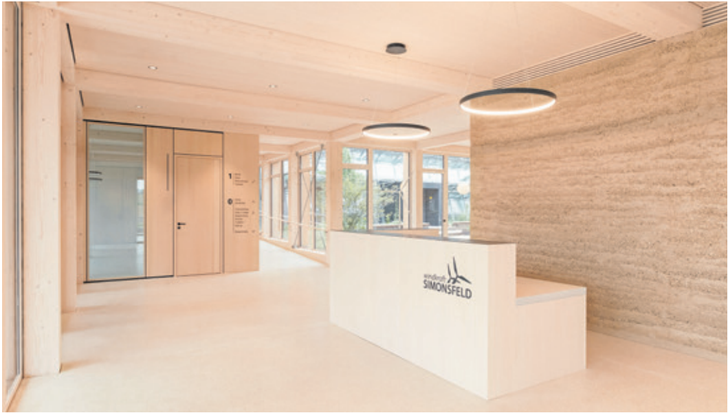
Eingangssituation und Empfang: Die Stampflehmwand im Hintergrund sorgt für ein gutes Raumklima, ist bauteilaktiviert und nimmt auch die Sanitär- und Nebenräume auf.
