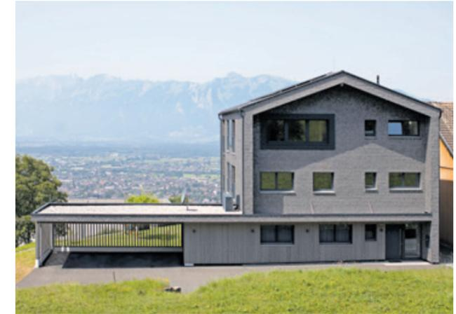
**DEZENT** Zwischen die zwei Fenster der Südfassade sind Photovoltaikpaneele integriert.
