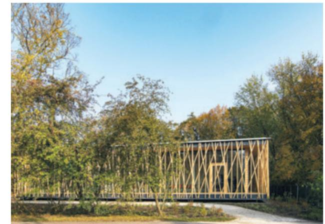
**DOPPELTE FASSADE** Das Flechtwerk aus Rundholzstäben zieht sich wie ein Band um die innere Fassade, die im Norden geschlossen, im Süden komplett, sonst teilweise verglast ist.
