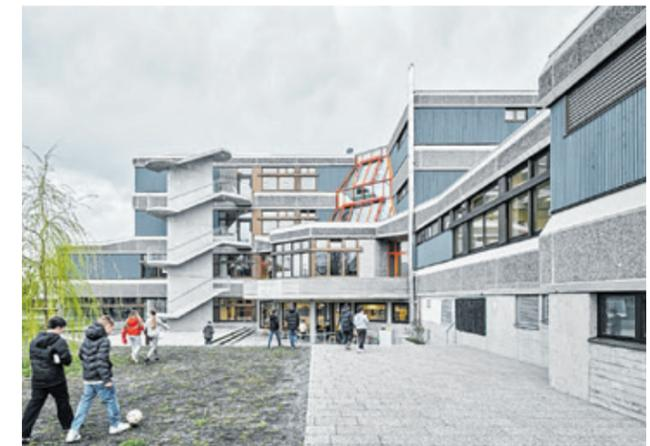
**DIE ALS RIESIGE SKULPTUR** daher kommende Fluchtstiege an der Rückseite des Baukörpers ist neu und komplett aus Sichtbeton gebaut. Die Geländer sind zart und aus Metall.
