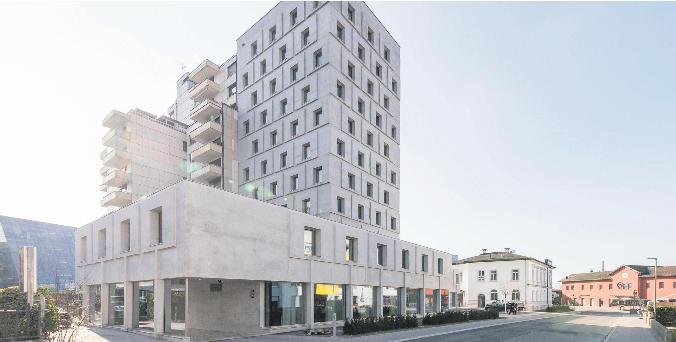
**AUS DEM IN Z-FORM** breit hingelagerten zweigeschößigen Sockel wächst der Zimmerturm in die Höhe. Gebaut Stockwerk für Stockwerk in Ortbeton, strukturiert durch große, breit umrahmte Fenster.
