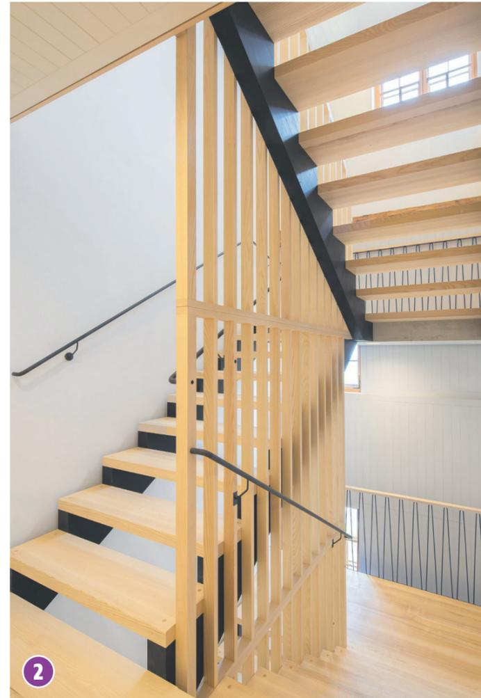
**2** Die alte, einläufige Stiege wurde durch eine neue Eichentreppe ersetzt, deren Konstruktion mit Stiegenwangen, lichtdurchlässigen Stufen und einer Harfe aus Holz sehr leicht ist.
