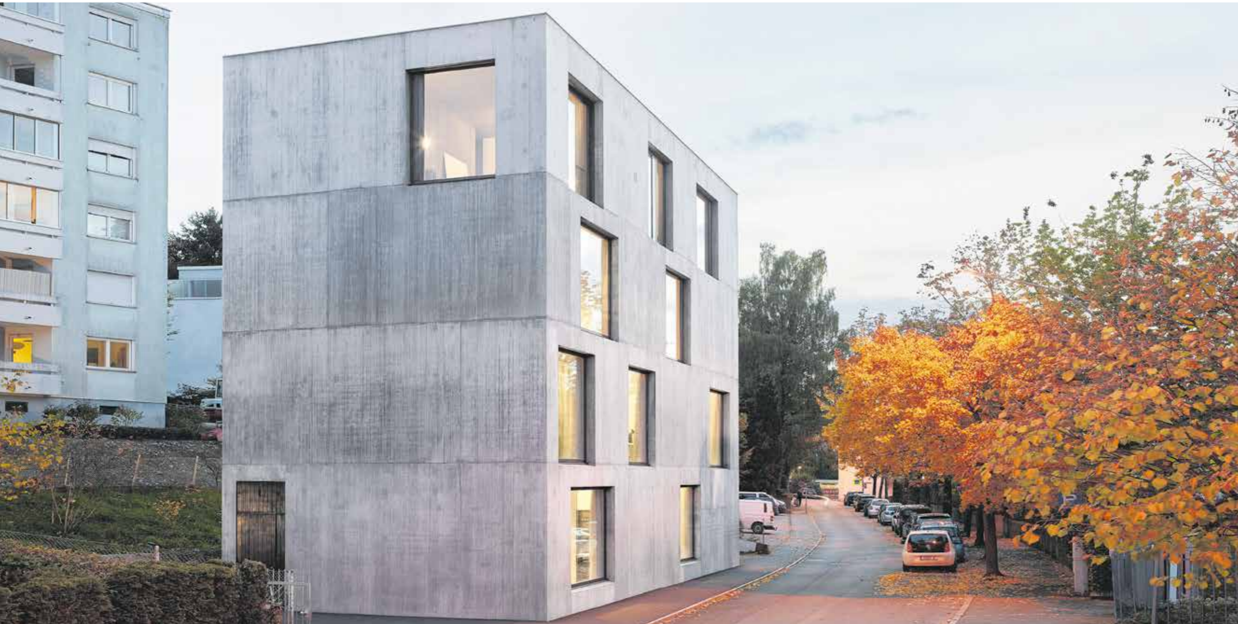
GERADLINIG UND UNMITTELBAR 22 Meter lang, 9 Meter breit, vier Geschosse hoch, steht das Haus selbstbewusst an der Gehsteigkante.
