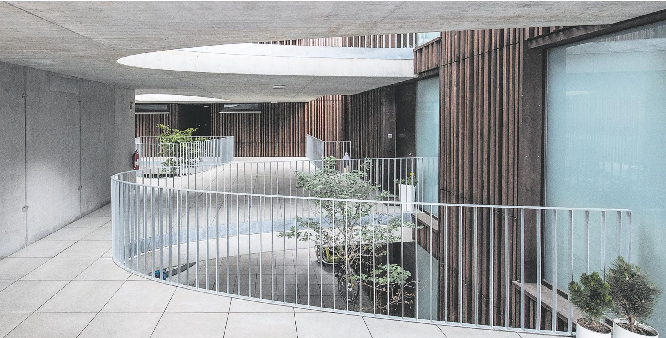
**HYBRIDBAU** Die Wohnanlage Kreuzbergstraße ist ein Hybrid aus Holz- und Massivbauweise. Die Außenwände sind aus vorfabrizierten Holzelementen gebaut, die Sockelzonen und Decken aus Beton.
