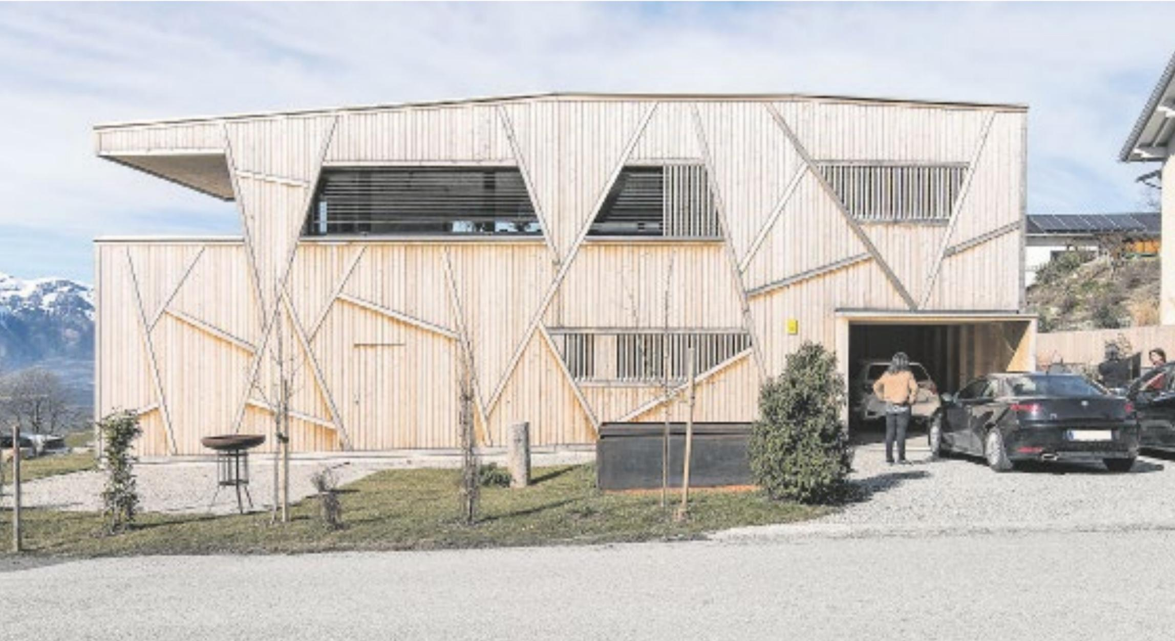
**DIE NORDOST-FASSADE** des auf dem leicht abfallenden Grundstück auf einer betonierten Bodenplatte stehenden hölzernen Baukörpers mit seinen leicht nach außen geknickten Längsfassaden ist komplett geschlossen.
