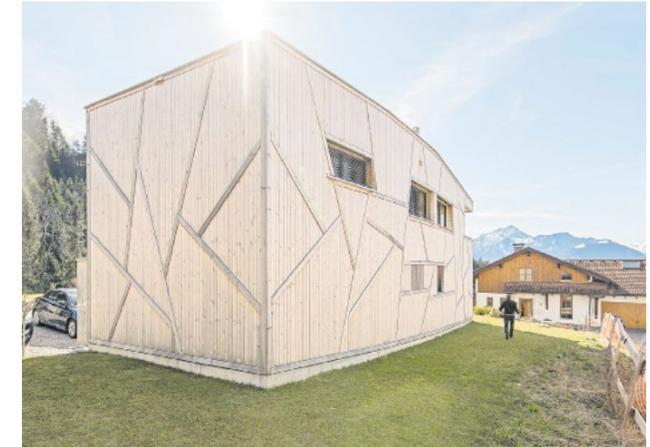
**DIE UNREGELMÄSSIG** als geometrisches Muster zelebrierte, teilweise vertikal geschlitzte äußere Hülle des Hauses Theurl schiebt sich teilweise auch über die dreifach verglasten Holz-Alu-Fenster.
