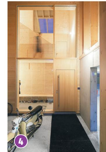
**4** Das aus sechs Zentimeter dicken Schichtsperrholzplatten konstruierte Stiegenhaus mit seinen lose eingehängten Stufen ist vom Eingang bis unter den Giebel rund sieben Meter offen.
