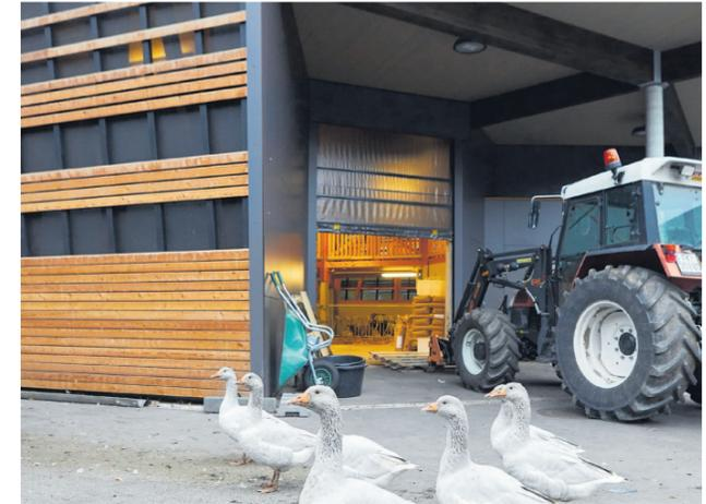
**ALS AUBENKLIMASTALL** wird das Bauwerk ganz ohne Technik durch das dunkle, aber licht- und luftdurchlässige Netz hinter dem lockeren Fassadenschirm aus Lärchenholz belüftet. Die gesamte technische Infrastruktur des Gebäudes kommt in dem kleinen Wirtschaftsraum neben der Einfahrt unter.
