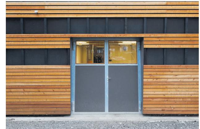
**SCHRÄGE FASSADENFLÄCHEN** geben dem schlichten und insgesamt sehr pragmatisch gestalteten Baukörper Eleganz und Leichtigkeit. Die Geometrie trägt außerdem zum konstruktiven Holzschutz der horizontalen Schalungsbretter bei.
