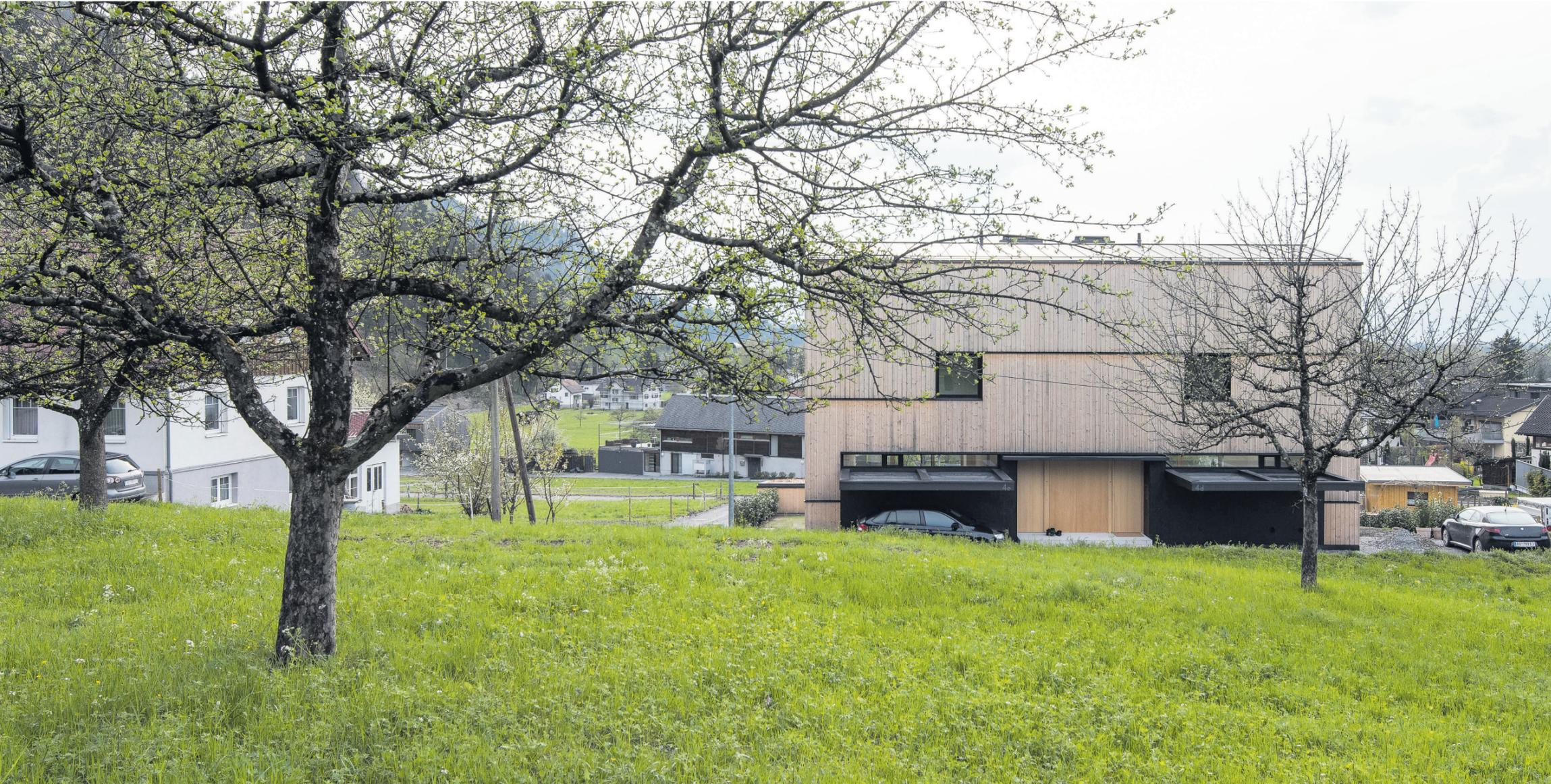
**DAS HAUS BUENDETELE** wird von unterschiedlich breiten Fichtenlatten in mehreren Rauheitsgraden vertikal ummantelt. Zelebriert als raffiniertes, horizontal durch zarte dunkelbraune Linien strukturiertes flächiges Muster.
