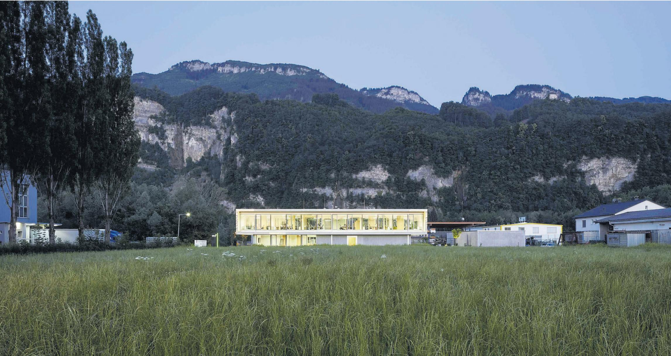
**EIN HYBRID** aus Beton- und Holzbau ist das neue Betriebsgebäude von MIA Systems in Hohenems. Eigentlicher Bauplatz ist eine mit 50 Pfählen im labilen Gelände verankerte Betonplatte.
