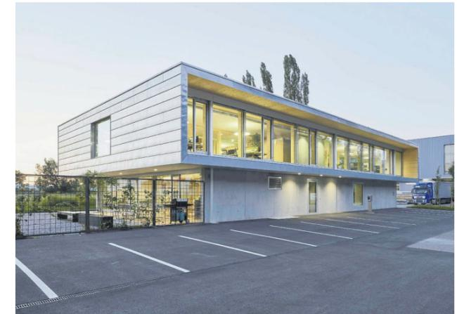
**WEIT AUSKRAGEND** über dem betonierten Erdgeschoß sitzt das ganz aus Holz gebaute obere Geschoß. Das außen allerdings mit in Stehfalzbahnen verlegtem verzintem Edelstahl ummantelt ist, dessen Farbigkeit täuschend ähnlich der des Betons ist.
