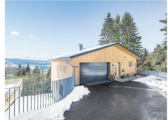
**BELEBTES HOLZ** Umhüllt wird der von heimischen Handwerkern aus vorfabrizierten Elementen errichtete Bau mit einer Außenhaut aus vertikal angebrachten Fichtenlatten.
