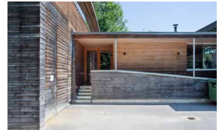
BESONDERES DETAIL: Sehr schwergewichtige Menschen nehmen diese Rampe, damit sie direkt auf dem Rücken der Pferde aufsteigen können.
