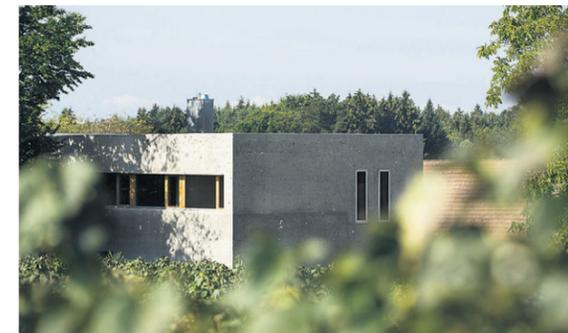
**Der fünfjährige Till** fühlt sich in „seinem“ Haus sichtlich wohl. Die Außenmauern sind 45 Zentimeter dick und aus Beton gebaut, dem als dämmender Zusatzstoff Glasschaumstoff beigemischt ist. Die Außenhaut hat Ralf Bernhardt eigenhändig gestockt.
