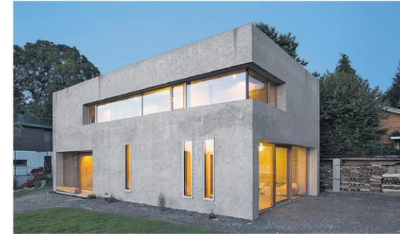
**Alurahmen** haben die schmalen hohen Fensterschlitze, Rahmen aus Holz die Fensterbänder. Die auf dem flachen, beklebten Dach liegenden Photovoltaikmodule liefern Strom für die Warmwasserbereitung.
