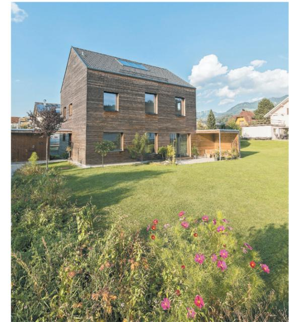
**Holzfassade** Über der massiven Bodenplatte aus Stahlbeton ist das Wohnhaus als reiner Holzbau ausgeführt. Die Fassaden sind mit horizontal verlaufenden, vorvergrauten Fichtenbrettern verkleidet, an den Giebelseiten bis unter das Dach.
