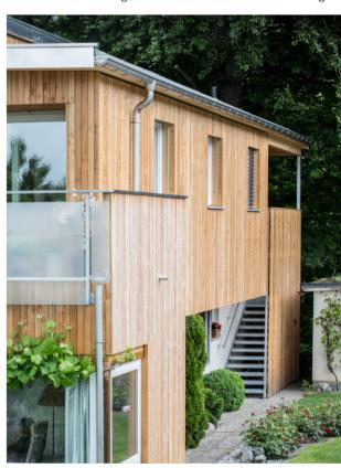
**Zum Tal hin** leicht auskragend ist die neue Holzkonstruktion auf den Bestand gesetzt. Das Dach ist eine reizvolle Kombination aus Fast-Flachdach und Pultdach
