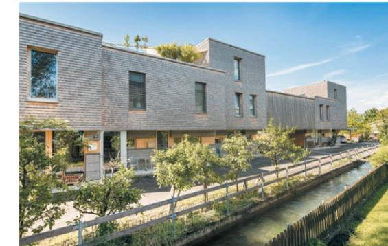
**Holzbau** Der in Passivhausqualität errichtete Holzbau besitzt in weiten Teilen eine Holzschindelfassade. Das verbindende Element in der Mitte ist mit vertikal verlaufenden Holzlatten verkleidet.
