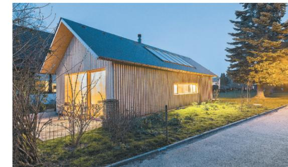
**Scheunenartig** Bei genauem Hinsehen erkennt man die unterschiedliche Bearbeitung des Holzschirms aus Fichte. Die vordere Ebene ist gehobelt, die hintere sägerau.
