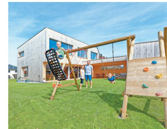
**Fensterspiele** Als raffiniertes gestalterisches Element sind die mehr oder weniger großen Holz-Alu-Fenster in die mit unterschiedlich breiten Fichtenlatten verkleideten Fassaden geschnitten.
